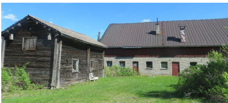
Kuva 13 ja Kuva 14. Alueella sijaitsevissa pihapiireissä on säilynyt myös vanhoja talousrakennuksia. Kivina- vetta, kookas sementtitiilinavetta ja hirsirakenteinen puoji ovat esimerkkejä maaseudun rakennusperinteestä.
